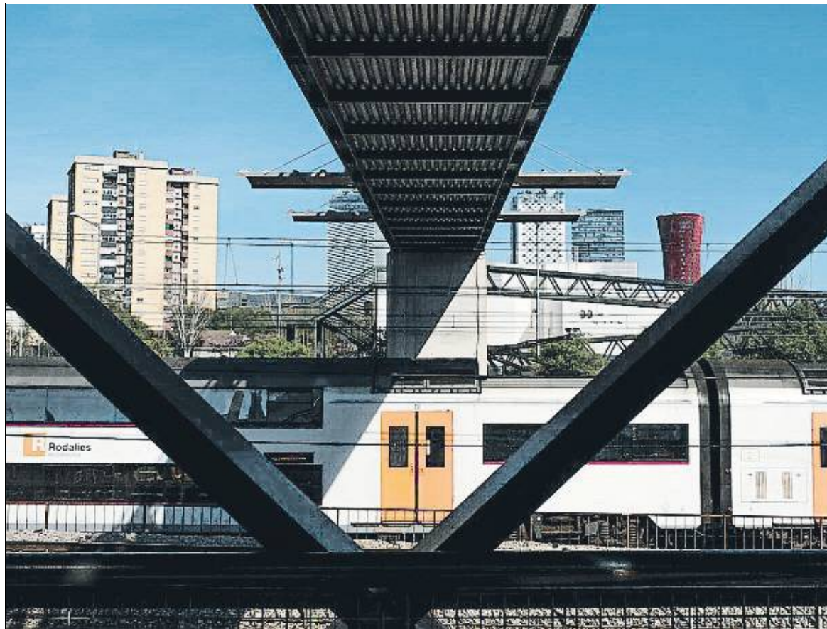
El soterramiento de las vías a su paso por l'Hospitalet es uno de los proyectos comprometidos
