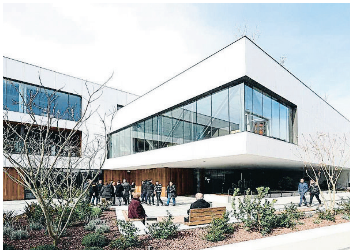
La plaza pública frente al nuevo edificio funerario de Sancho de Ávila
