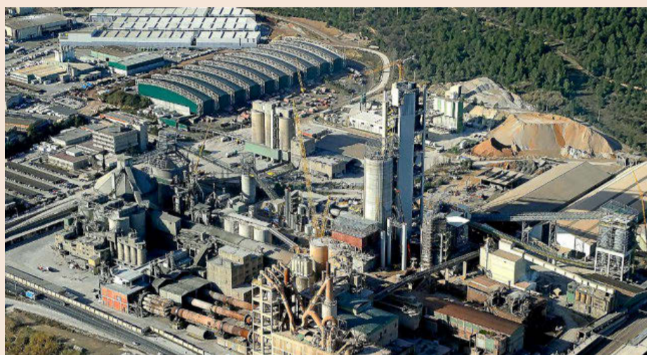
Planta de Cementos Molins en Sant Vicenç dels Horts, donde la empresa tuvo su sede social.
