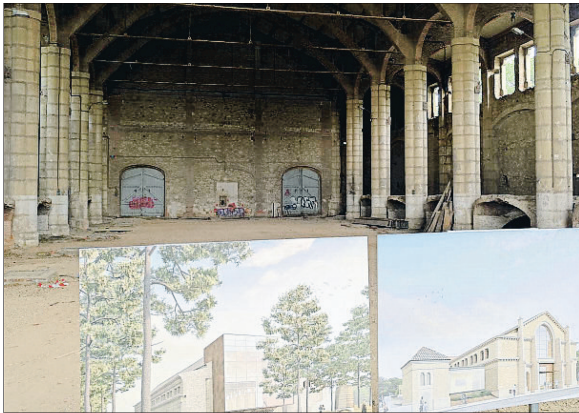
El proyecto prevé tirar la pared del fondo de la nave para construir una caja escénica con pared de cristal
