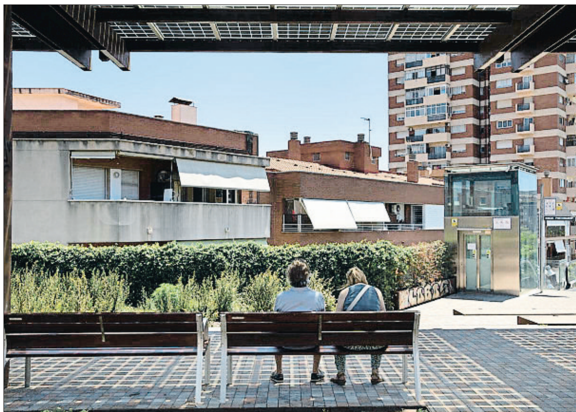
El piso de los demandantes, detrás de la vegetación actual, está a pocos más de dos metros del paseo
