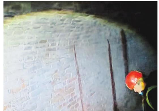
Interior del búnker antes de que fuera cerrado
