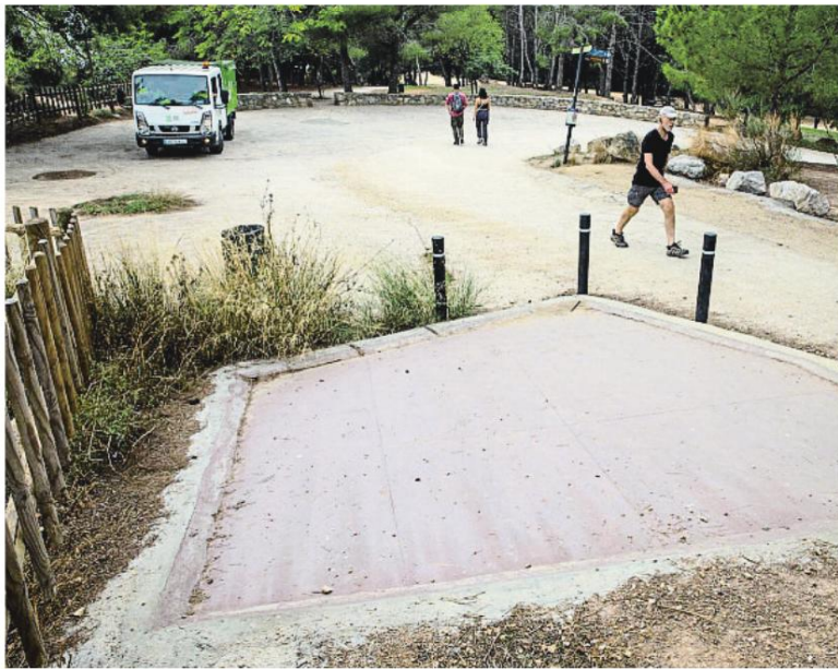
El Ayuntamiento de Barcelona ha tapiado el acceso a la galería subterránea por razones de seguridad
