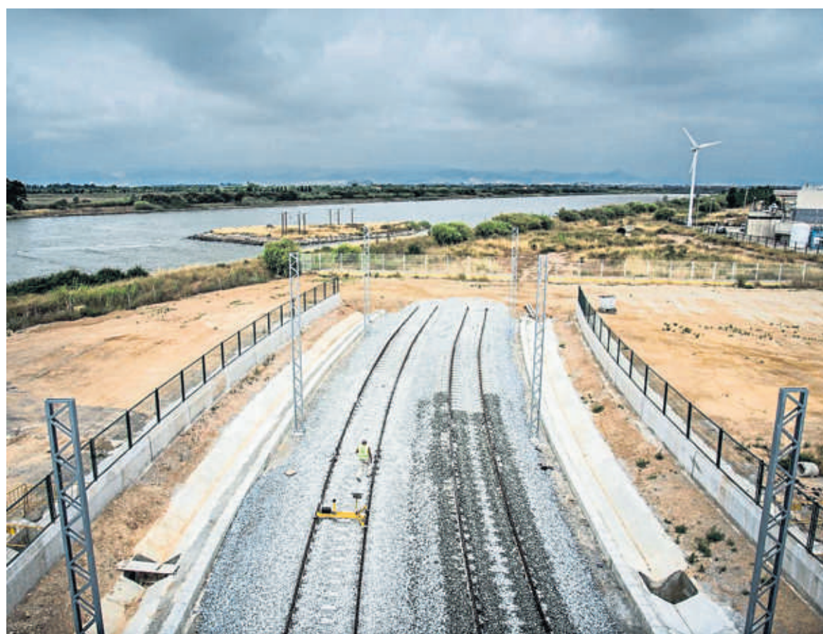
Vista de un tramo de vía ya ejecutado por el Port, sin conexión, junto al nuevo curso del río
